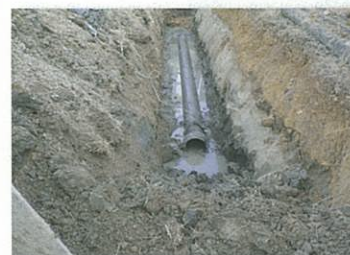
石綿管の布設状況
