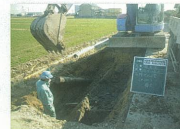
石綿管φ200mm 取り外し
