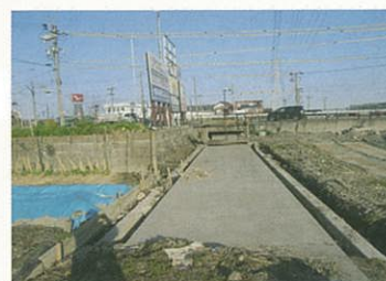
(改修前)既設コンクリート水路(蓋付)
