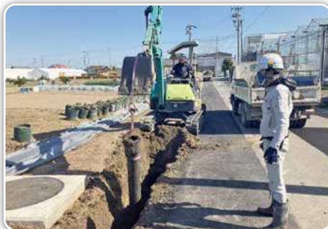
石綿管撤去状況
