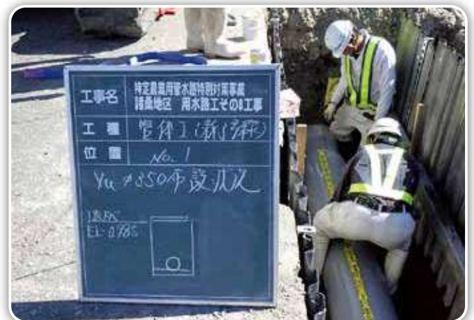
新設管布設状況
