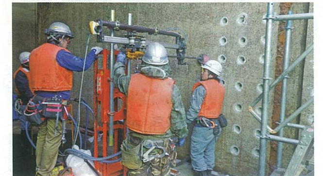
既設コンクリート削孔後、せん断補強筋設置
