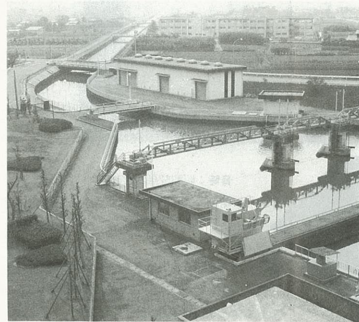
木曾川大堰取水口と海部幹線水路
