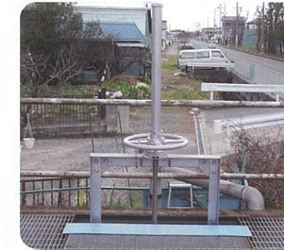
内佐屋支線の改修されたアームコゲートφ800mm
