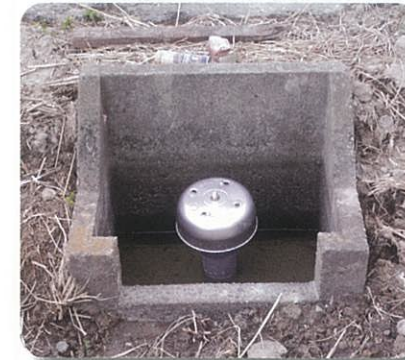
交換した給水栓
