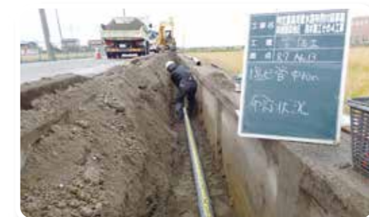
石綿管撤去状況(写真左)と 新設管布設状況(写真右)
