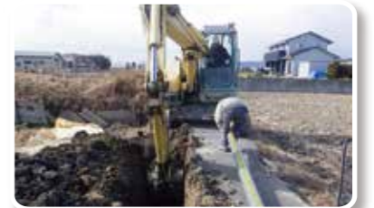
石綿管撤去状況(写真左)と新設管布設状況(写真右)
