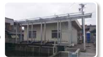
【竹之郷揚水機場】更新した配電盤(写真左)とポンプ吊上装置の設置(写真右)
