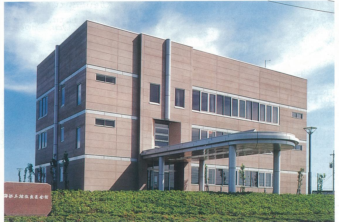
海部土地改良区会館
