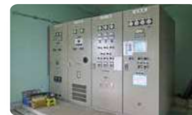
【服岡揚水機場】 更新した配電盤(写真左)と 塗装した場内配管(写真右)
