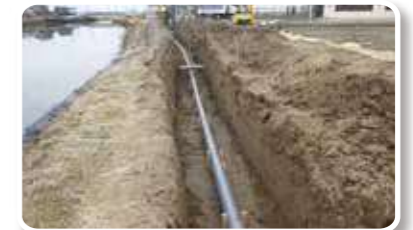
石綿管撤去(写真左)と 新設管布設状況(写真右)
