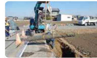
石綿管撤去(写真左)と 新設管布設状況(写真右)
