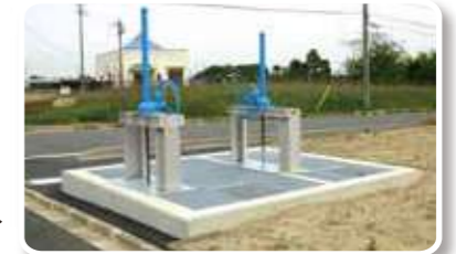
八開地区 藤ヶ瀬支線分水工▶
