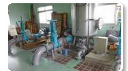
【服岡揚水機場】 更新した配電盤(写真左)と 塗装した場内配管(写真右)
