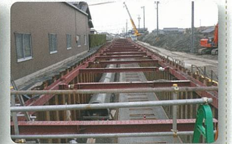
【開削工法】 FRPM管φ1,350mm ★幹線西支線水路
