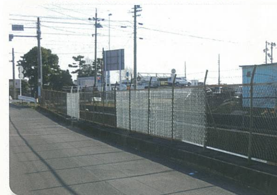
鍋田用水路のネットフェンスを補修しました。
