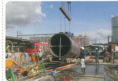
【沈埋工法】 FRPM管φ1,650mm ★市江支線水路
