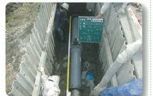
津島市古川町地内の制水弁の取替工事を行いました。
