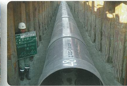
【開削工法】 FRPM管φ1,200mm ★内佐屋支線水路
