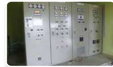
【松之郷揚水機場】更新した配電盤(写真左)と塗装した場内配管(写真右)
