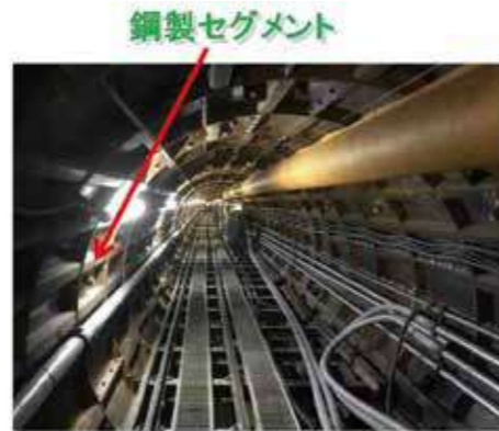
トンネル内状況
