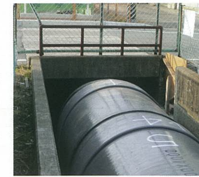
(FRPM管 φ1,500mm 配管工事)
