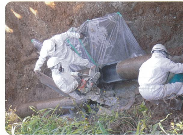
石綿セメント管撤去工事(他地区)
