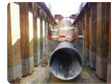
地盤沈下対策事業 八開地区 (開治支線)
