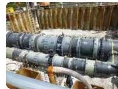
地盤沈下対策事業 愛西北部2期地区 (幹線西支線水路)
