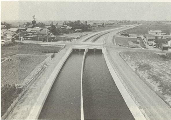
完成した海部幹線水路
